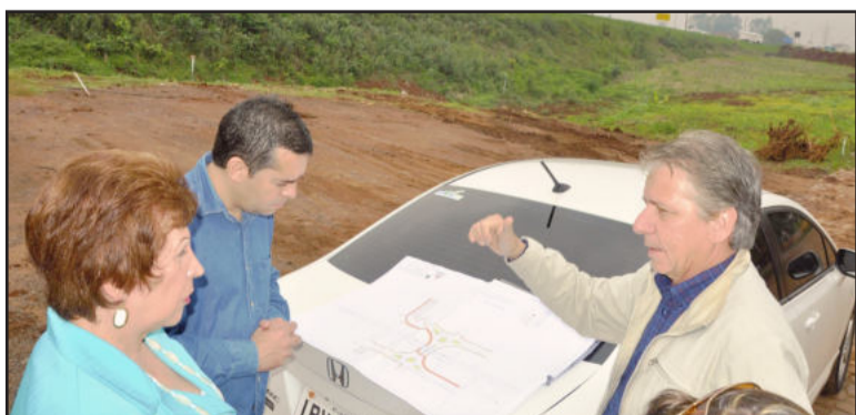
Paranhos, da Construtora Giovanella, detalhou as etapas da obra junto ao futuro túnel
