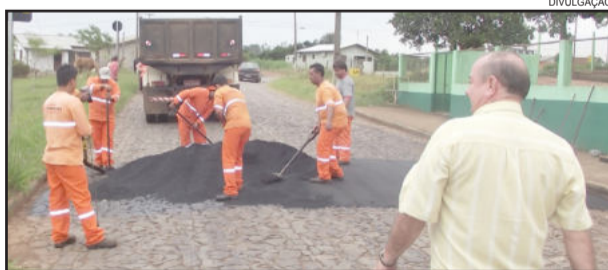
Instalação de quebra-molas objetiva reduzir a velocidade
