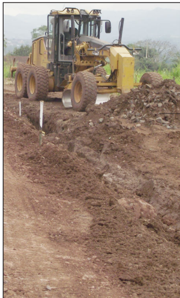
Melhorias nas estradas são realizadas
