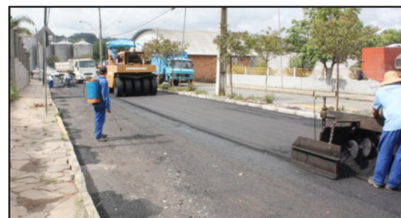
Pavimentação asfáltica avançou em um trecho da Buarque de Macedo
