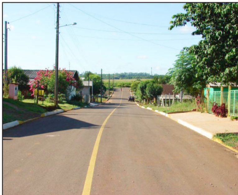
Rua 50 no Bairro Canabarro agora está pavimentada
