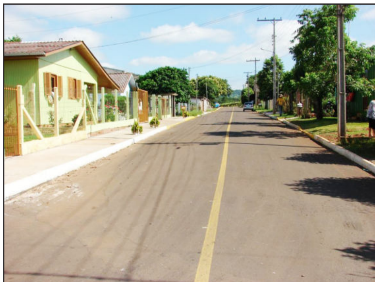
Rua 51 também foi asfaltada
