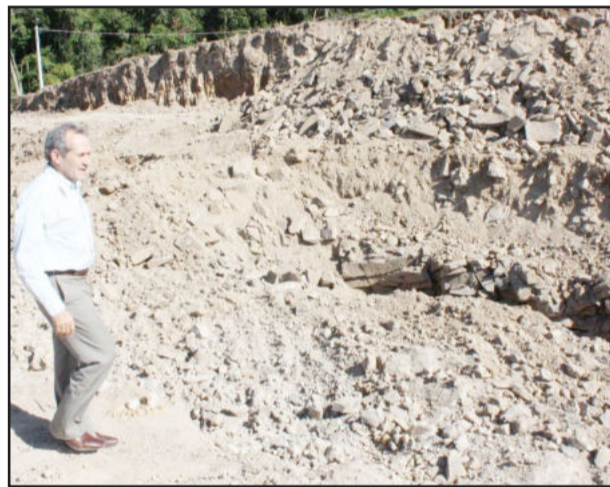
Loteamento São José
