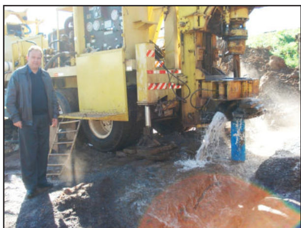
Poço artesiano para a obra
