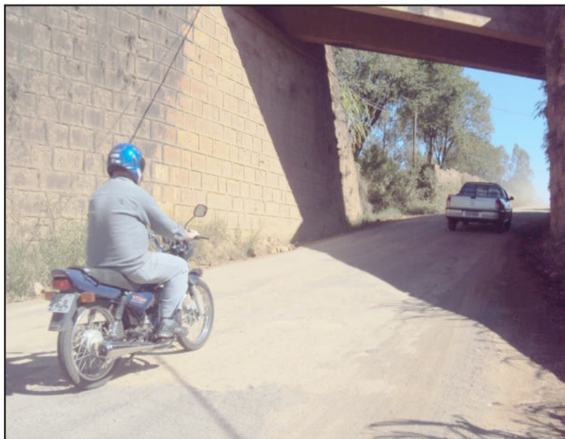
Mais um trecho de asfalto para a Rua 4 de Julho
