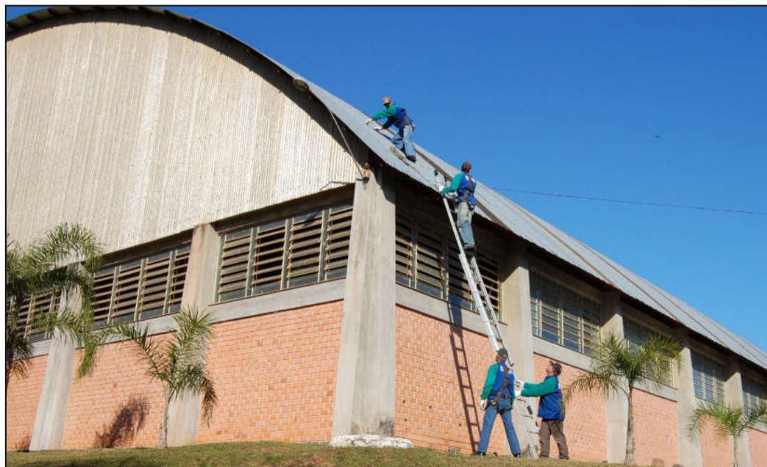
Profissionais realizam a substituição de telhas
