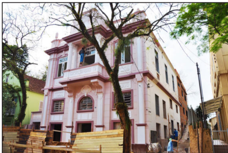
Prédio histórico para Secretaria de Educação ganha parte nova nos fundos
