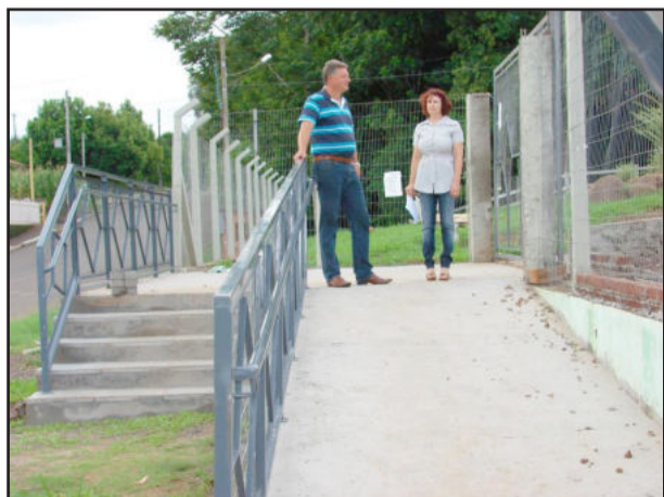
Rampa de acesso para portadores de necessidades especiais junto à Escola Alfredo Schneider
