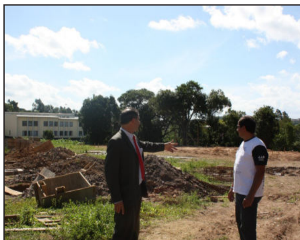
Obras do futuro ginásio no Bairro São José
