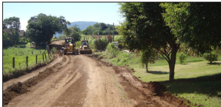
Asfaltamento iniciou em Linha Santo Antônio
