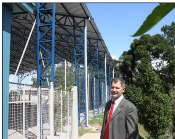
Cobertura na quadra do Centro Social São José
