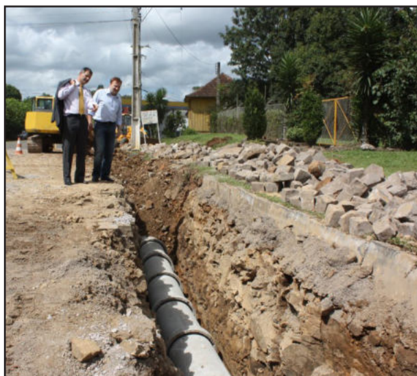
Canalização atende antiga reivindicação
