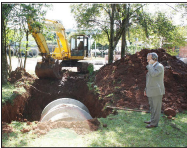
Obras pretendem evitar o alagamento das ruas
