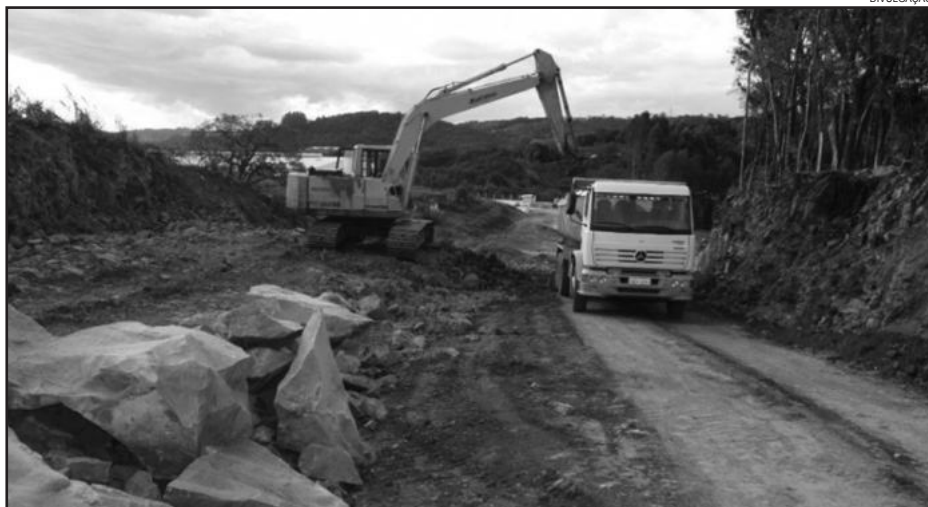
Programa de Incentivo Empresarial, Econômico e Social oferece serviços de terraplanagem com escavadeira hidráulica, motoniveladora e caminhões
