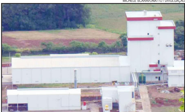
Nova Fábrica da Dália, em Arroio do Meio
