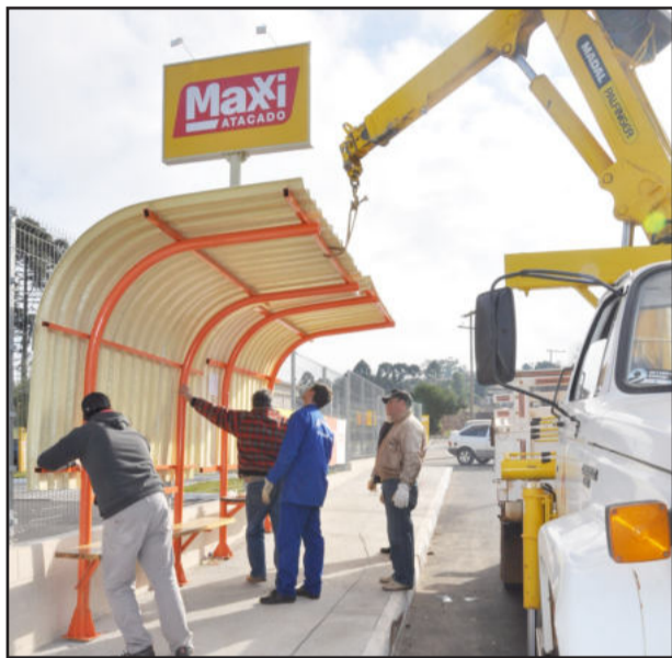
Parada de ônibus foi instalada em frente ao Maxxi Atacado
