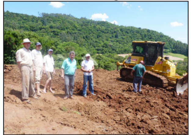
Prefeito conferindo a terraplanagem
