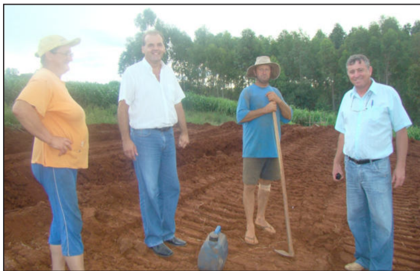
Máquinas da Prefeitura já prepararam a terraplanagem para construção do chiqueiro de Silério Diehl
