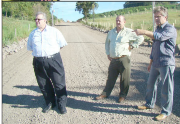
Visita de Ernani Althaus e Elemar Dickel à obra da Estrada Velha
