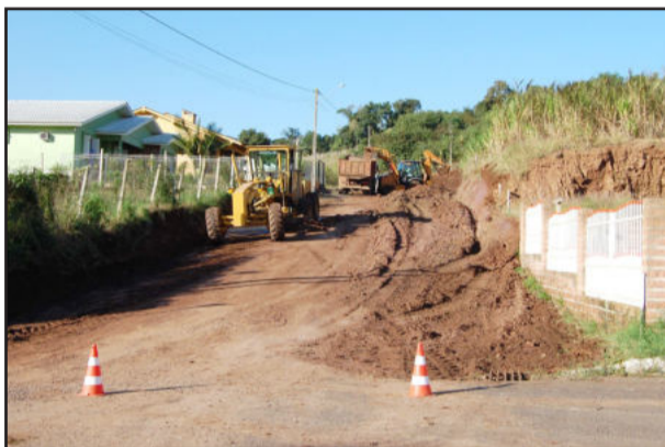
Máquinas realizam serviços de limpeza
