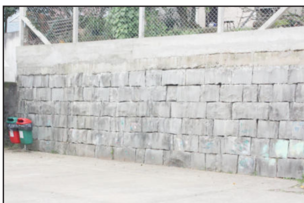
Muro protege quadra de esportes
