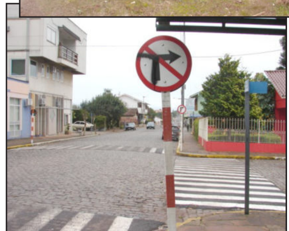
Placas derrubadas e pichadas
