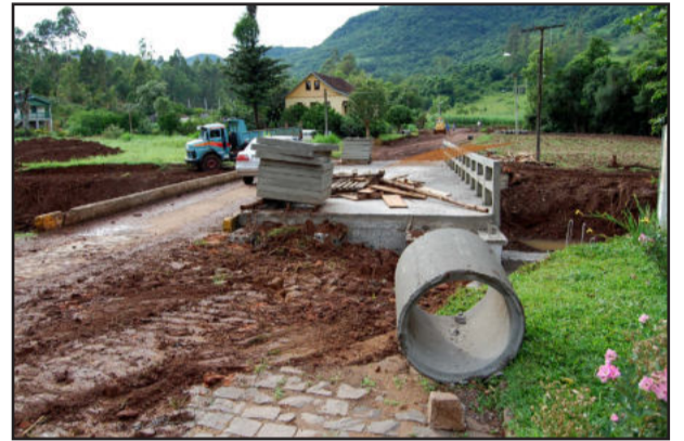
Ponte em reconstrução no Bairro Daltro Filho
