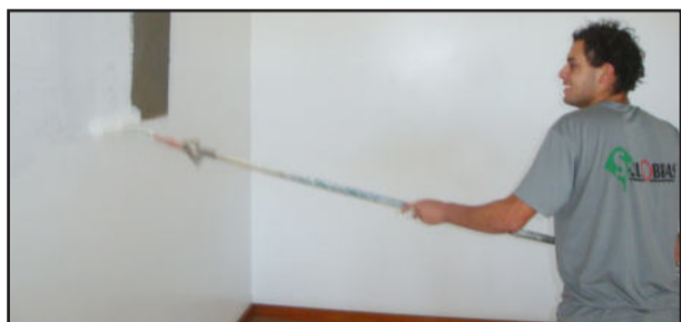
Sala que receberá biblioteca está sendo reformada
