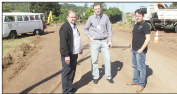
Obras para construir o viaduto começaram
