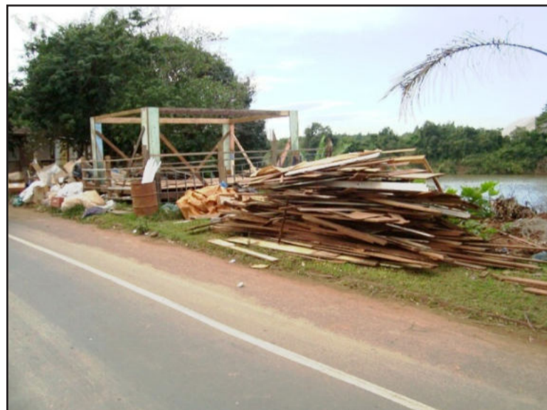
Casa estava sendo erguida às margens do Taquari
