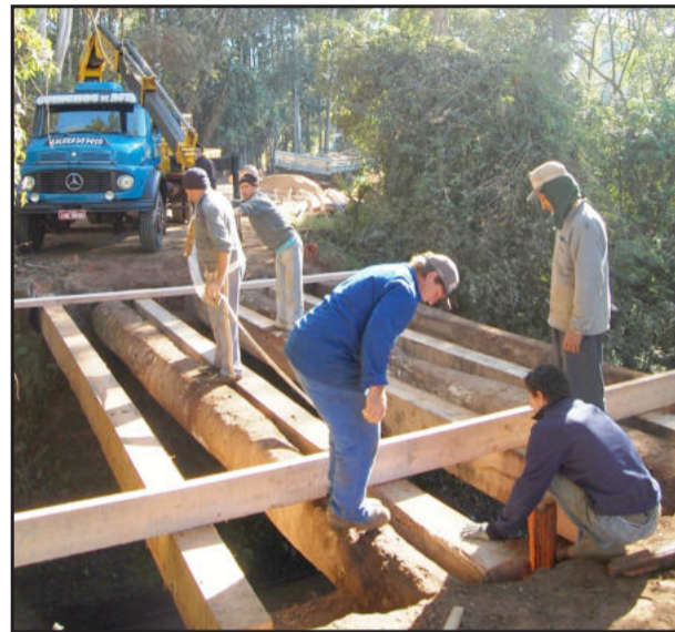
Ponte: vigas e tábuas substituídas
