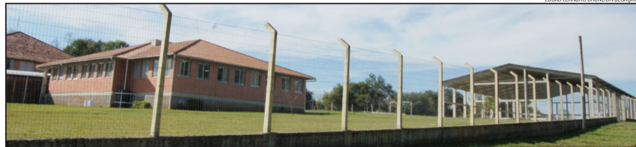
Ginásio de esportes da EMEF Alfredo Schneider
