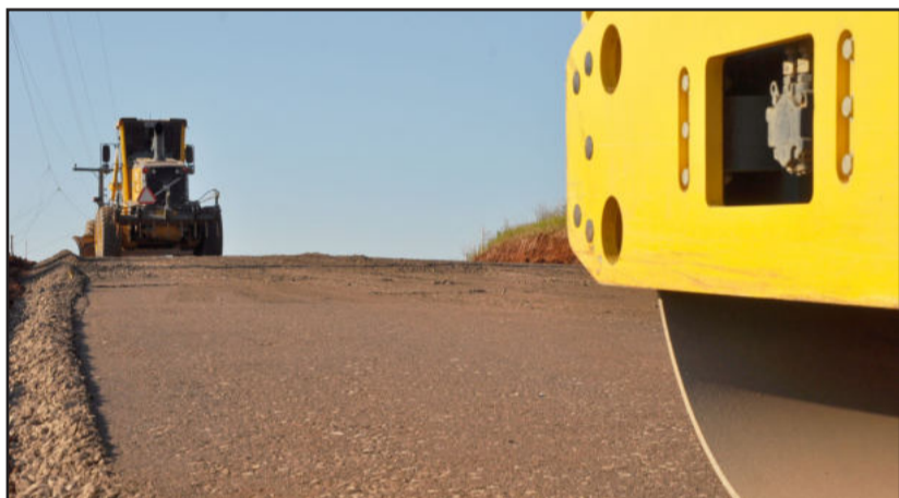
Máquinas já trabalham na Rua Alberto Schneider
