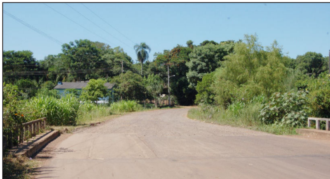
Asfalto iniciará a partir da ponte, sobre o pavimento com pedra irregular
