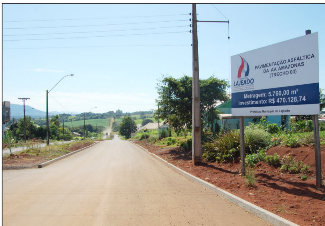
Trecho 3 está em fase final de obras
