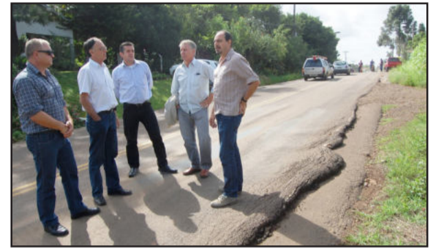
Equipe avalia estado da rodovia
