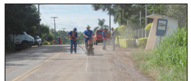
Início das obras foi nesta terça-feira
