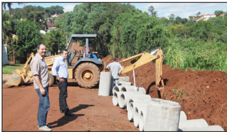
Fornari (E) e Lopes (D) satisfeitos com o início das obras
