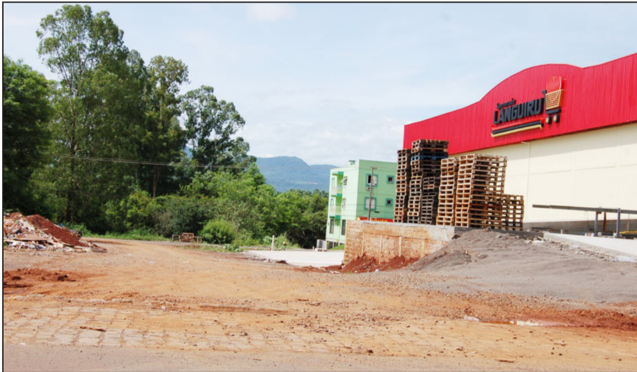
Quadra da Rua Senhor dos Passos a ser asfaltada
