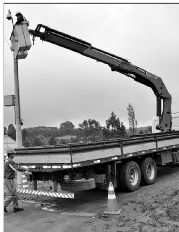
Começa a instalação das câmeras
