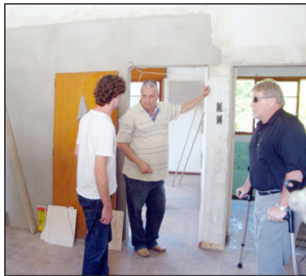
Obra de reforma foi fiscalizada pelo prefeito Celso Brönstrup (d); engenheiro Mateus Ruschel (e) e André Scheibel (c)
