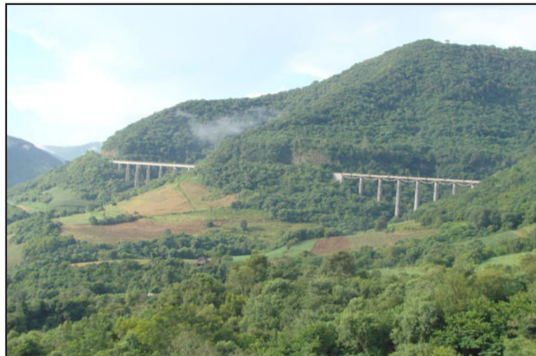
Ao fundo, o Viaduto 13 em Vespasiano Corrêa
