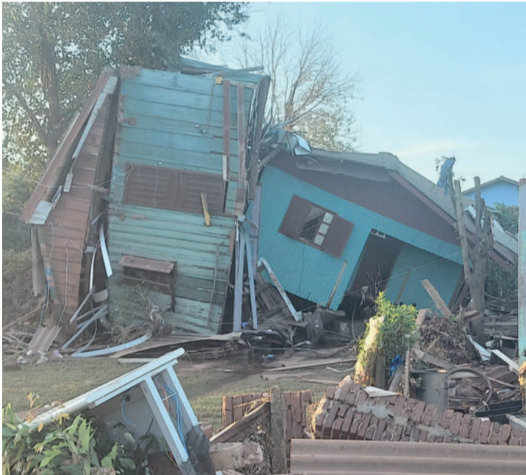
Casas foram arrastadas pela força do Rio Taquari, em Roca Sales
