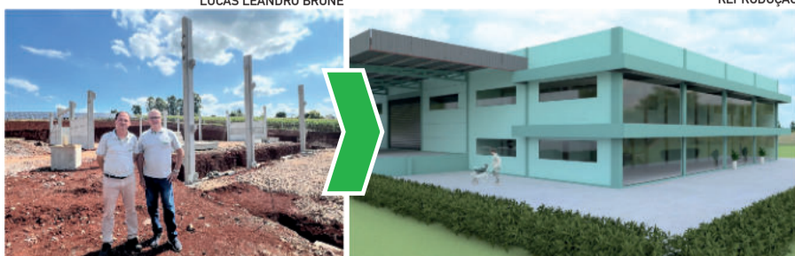
Lício Sulzbach e Édson Dahmer acompanham andamento da obra
