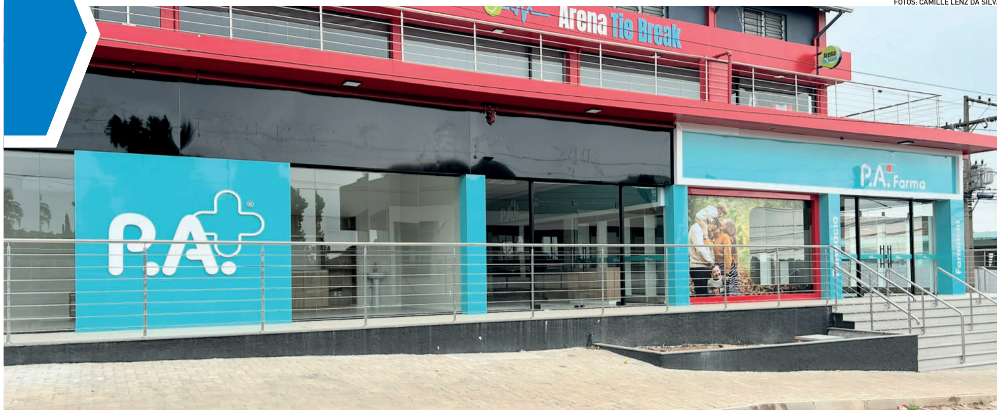
Ambulatório fica no antigo prédio da Blip
