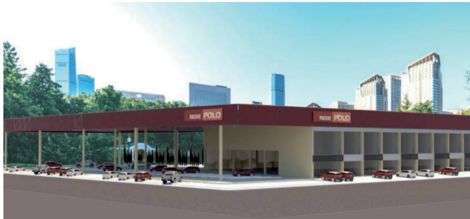
Empreendimento terá fácil acesso pela rótula de entrada do município
