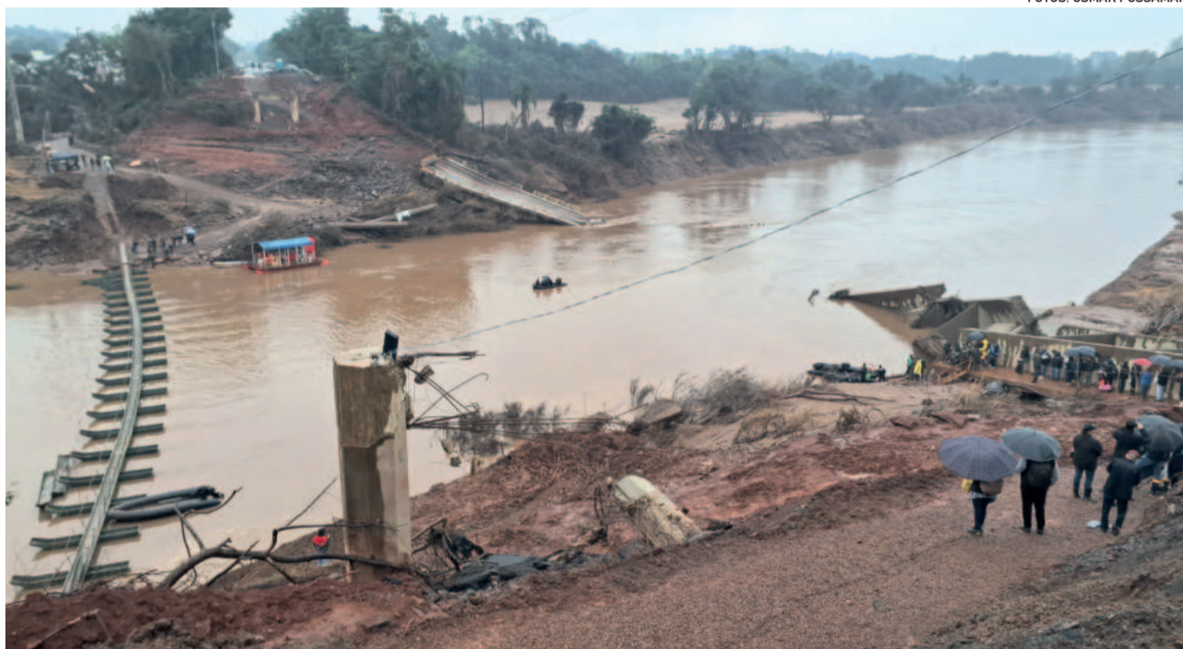
À direita, ponte da ERS-130 jaz destruída. Passarela do Exército é solução paliativa para aqueles que podem se locomover a pé entre os municípios
