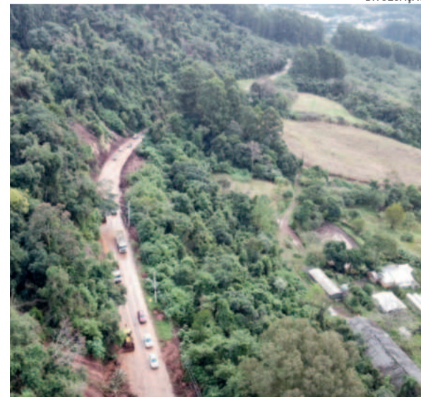
Principal acesso de Imigrante recebe desobstrução com máquinas e caminhões
