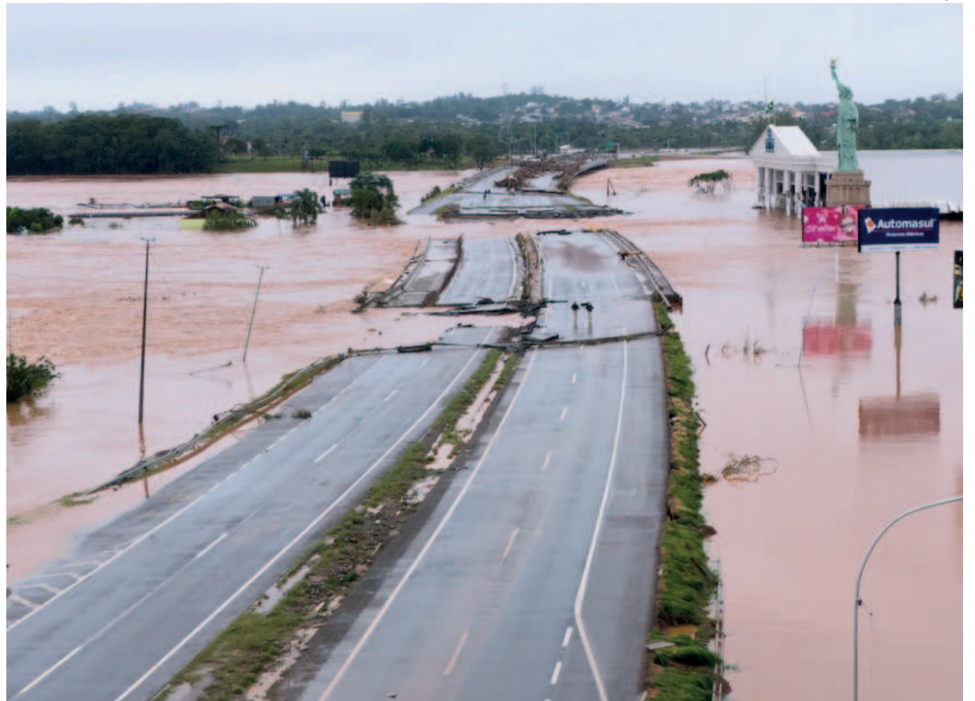
Pontes da BR-386 sobre o Rio Taquari foram desafios regionais e geraram grande apreensão
