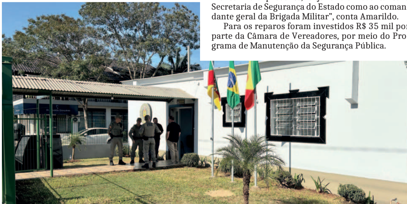
Restauro manteve as características originais do prédio, construído na década de 1980
