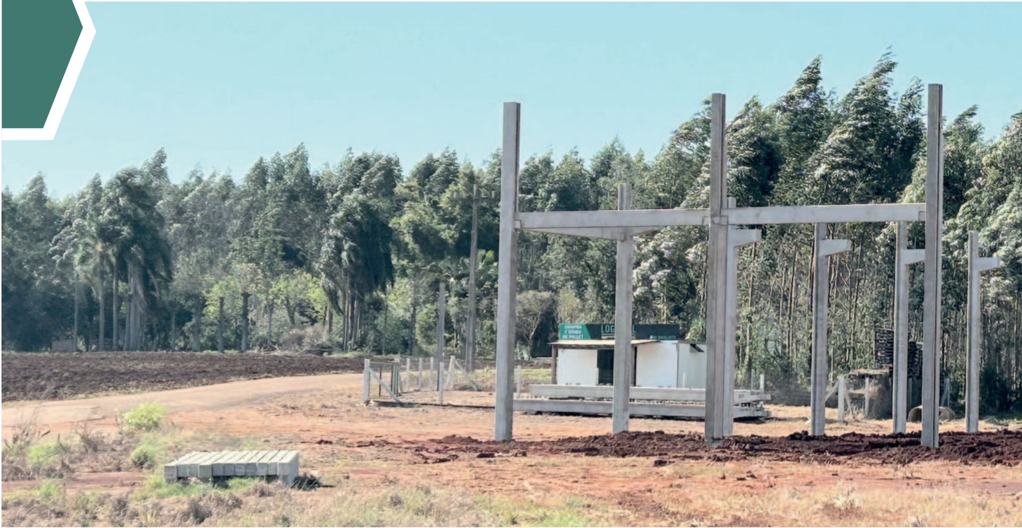
Construção de novos pavilhões dão o tom ao crescimento do município
