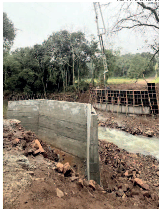
Município dá andamento à reconstrução das pontes
