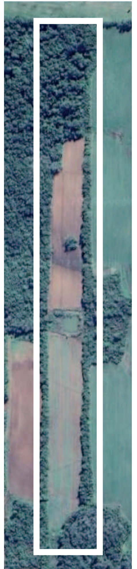
Terreno cedido fica atrás da Certel Artefatos de Cimento
