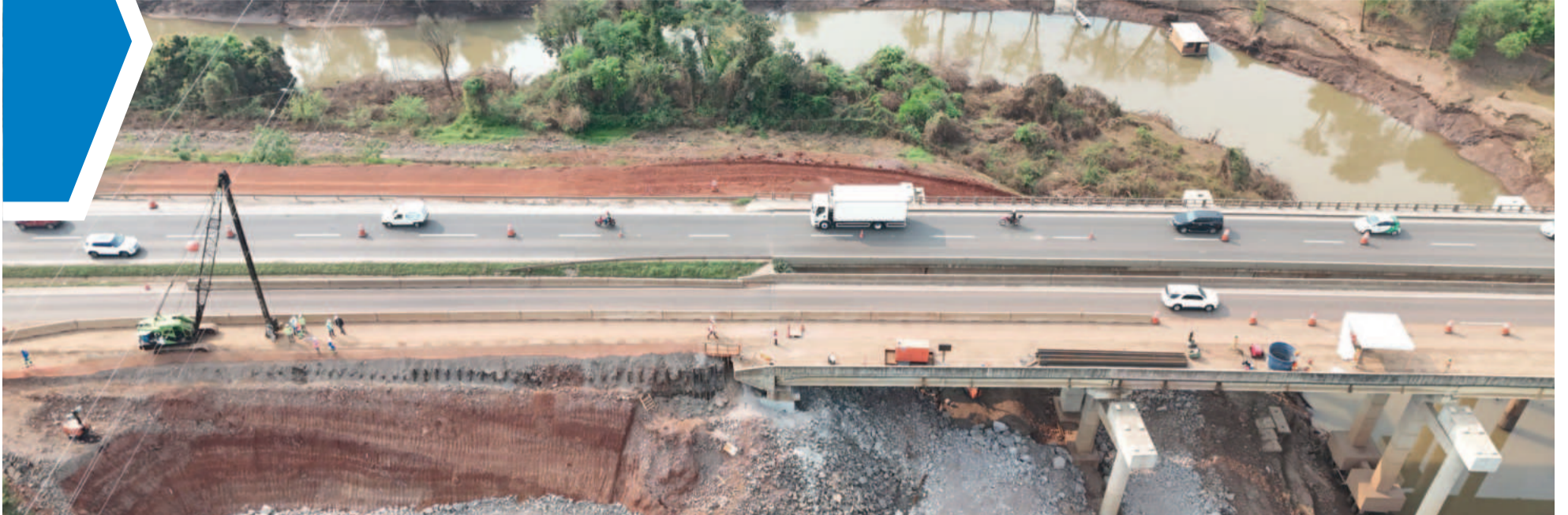
Obras da CCR ViaSul sobre o Arroio Boa Vista
