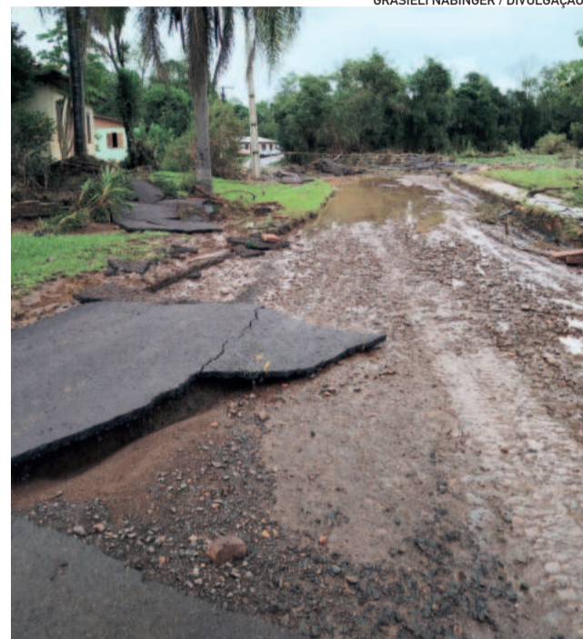
Asfalto em Pontes Filho
