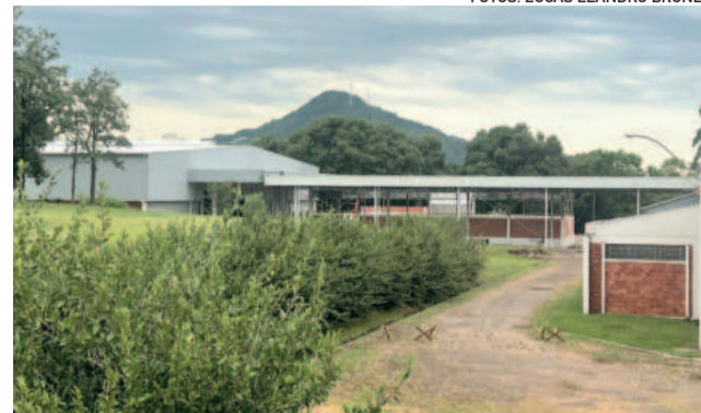
Prédio ao fundo recebeu ampla reforma, especialmente no telhado durante 2024
