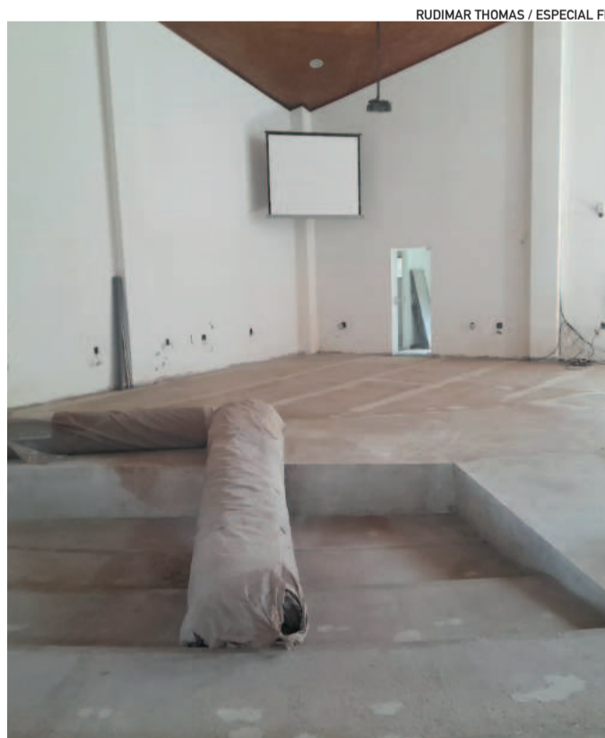
Plenário da Câmara foi completamente destruído
