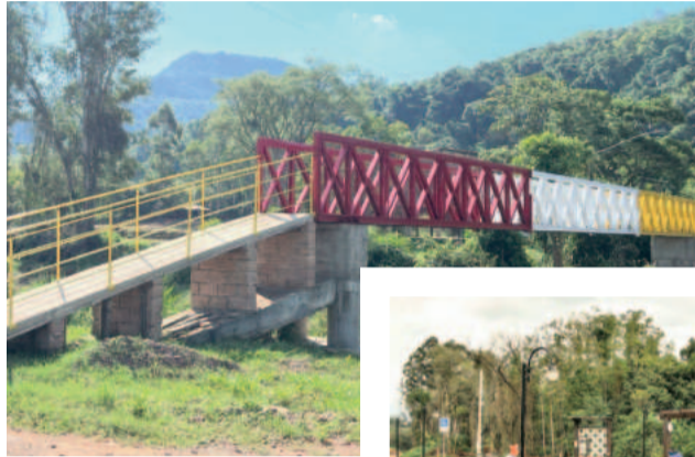
Passarela metálica de Seca Baixa foi reconstruída
