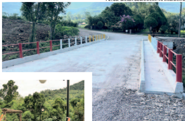
Ponte do Estaleiro também foi reconstruída
