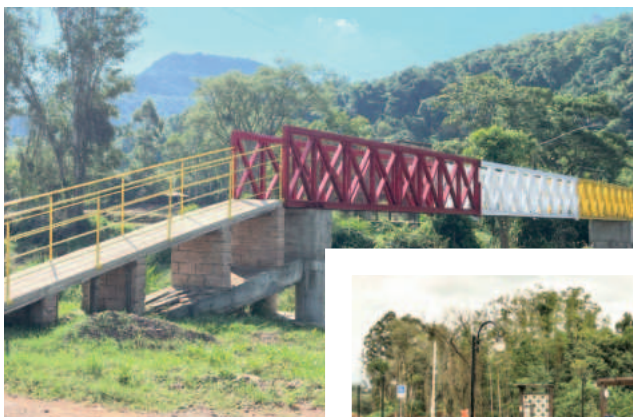
Passarela metálica de Seca Baixa foi reconstruída
