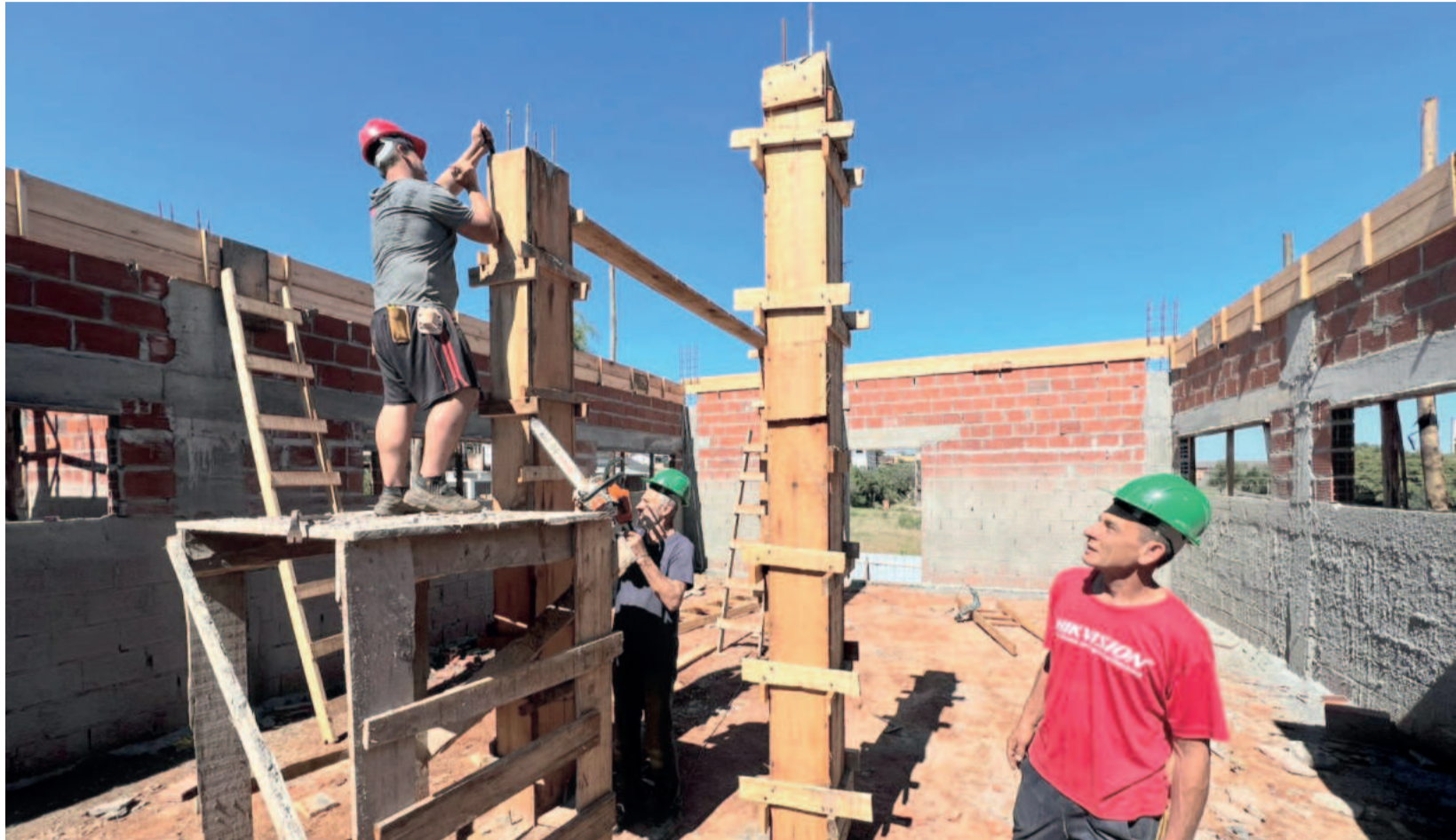
Obra está em plena execução e tem previsão de conclusão e entrega para o início de 2026
