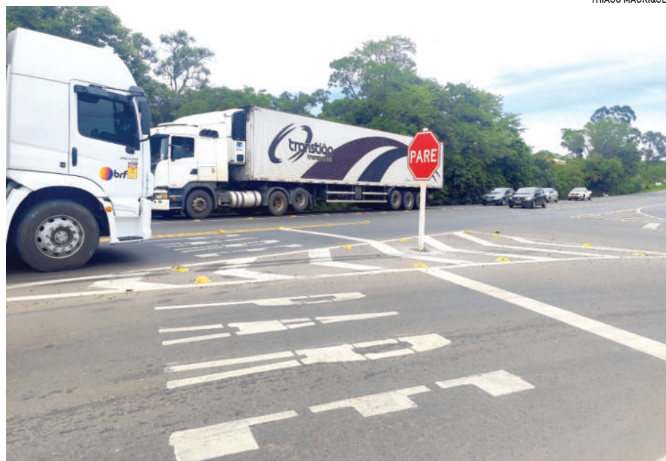
Na intercessão entre a RSC-453 e a João Fell, placas de “pare” interrompem fluxo da rodovia para dar preferência à conversão
