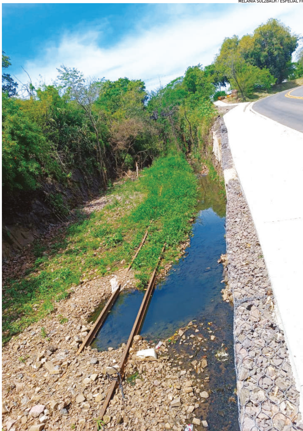
Faixa de domínio compreende terrenos ao lado dos trilhos
