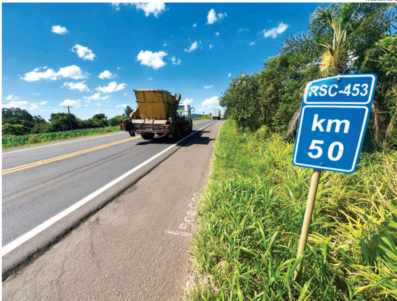
Local originalmente previsto para o pórtico era o km 50
