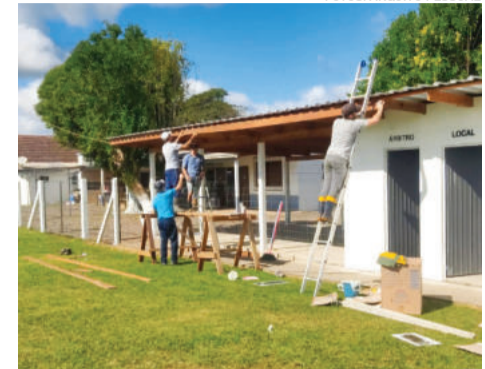
Após a baixa das águas, voluntários ajudaram na limpeza e obras na localidade
