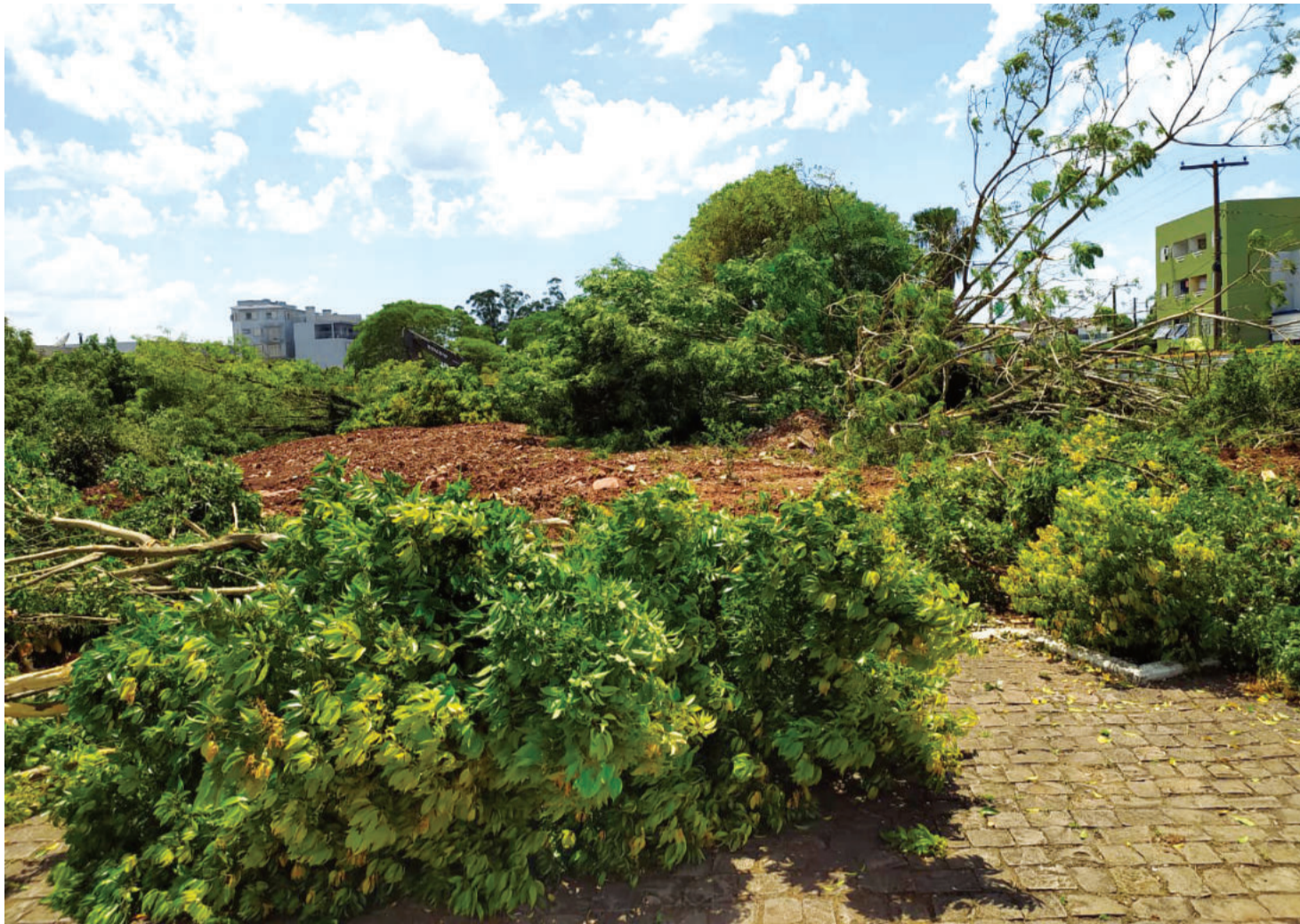
Bosque da Languiru virou um canteiro desértico de obras
