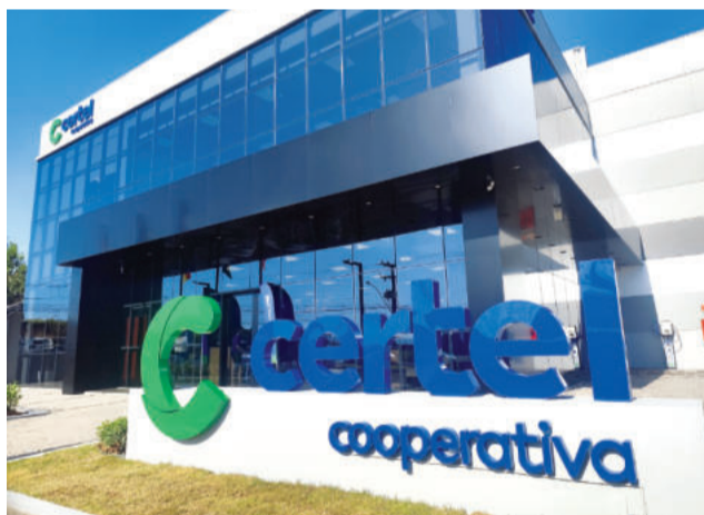
Nova sede operacional concentra equipes técnicas, administrativas e estrutura de apoio
